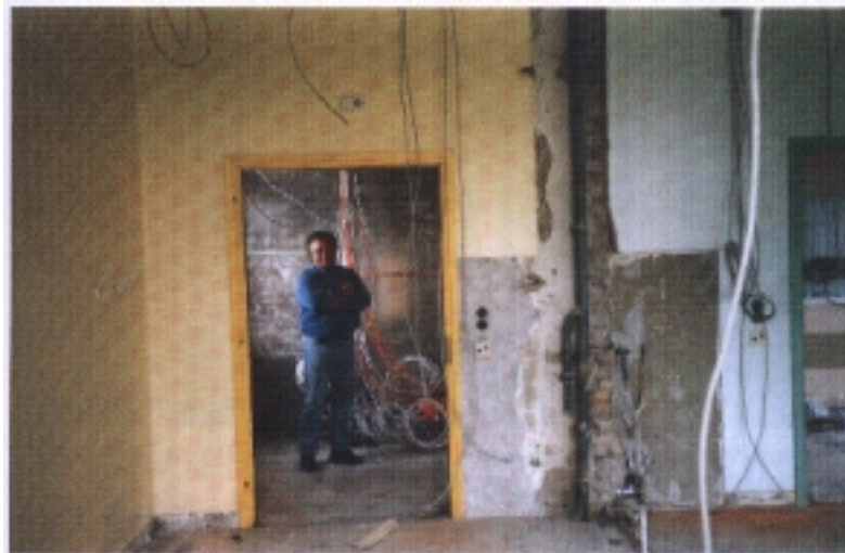
Der technische Leiter Schmidt im Baustellenchaos
